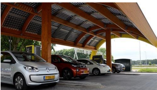
Garagem com painéis solares transparentes e estação de carga
