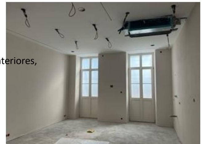
Início dos trabalhos de construção em julho de 2022, todas as paredes interiores, 4 andares. Renovação na zona do rodapé (até 1,20 m de altura) com aerius FP310, todas as superfícies de parede até à altura do teto com reboco isolante de cal Emys, incluindo todos os vãos das janelas.
